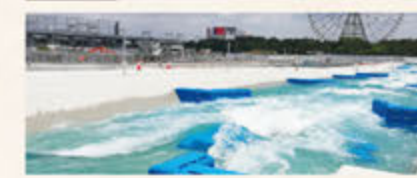
▲ 人工カヌー・スラロームコースの水流作りに貢献した国内最大級の水中ポンプSSP-1350GS型(吐出し口径1350mm、出力350kW)
