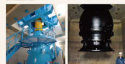
▲ 長野県の排水機場に納入したツルミ最大口径の立軸斜流ポンプ(吐出し口径1800mm、出力420kW)
