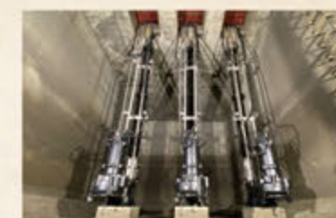
▲ 雨水排水機場に設置され洪水対策用に貢献する高効率水中ノンクログポンプB型
