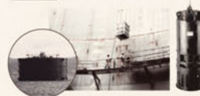
▲ 明石海峡大橋のケーソンに据え付け作業中の 水中ポンプとケーソン沈設に活躍した 耐海水用水中ポンプKRS-1255型
