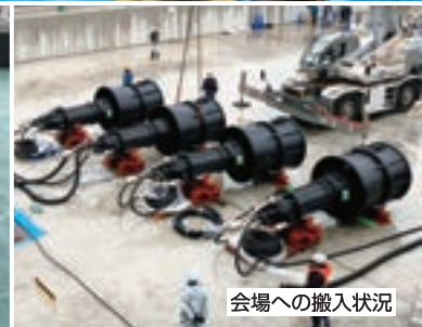
ポンプ稼働状況
