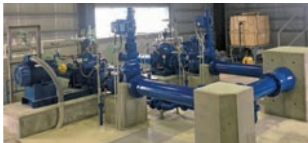
据付状況①
