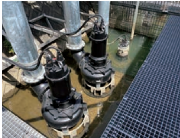
ポンプ据付状況①
