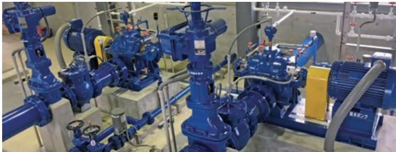
据付状況②
