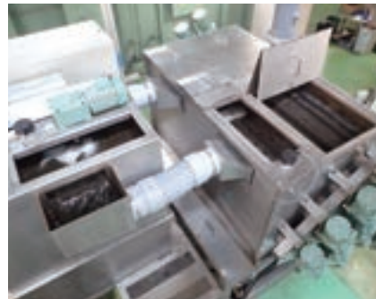
稼働状況（開放時）
