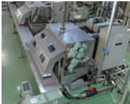
据付状況②
