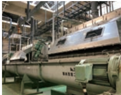
据付状況①
