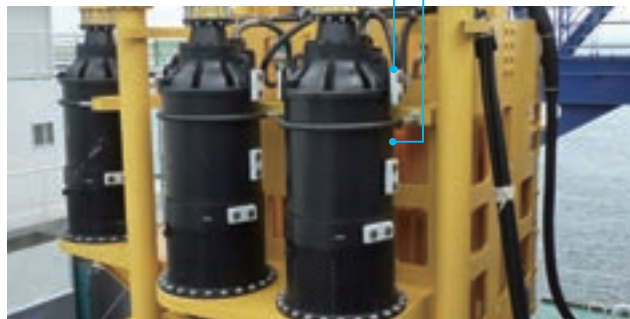
ポンプ据付状況
