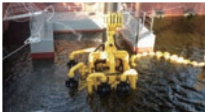
ジェットポンプ海中投入開始
