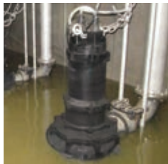
ポンプ据付状況
