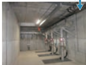
ポンプピット 上部
