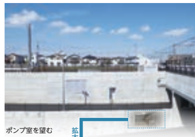
ポンプ室を望む
