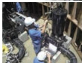
ポンプ据付後の固有振動数測定状況
