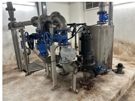
地下鉄のトイレ排水として スマッシュポンプ採用
