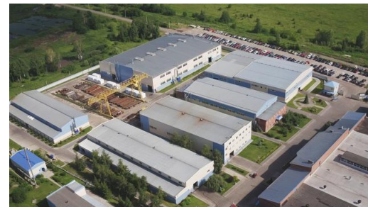
工場内の水中ポンプを他社製から スマッシュポンプに切り替え
