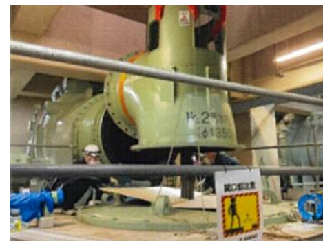
常設ポンプのメンテナンスに伴う 引上げ作業
