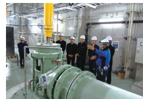
ポンプ場内での説明の様子
