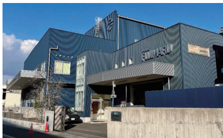
本社工場及び新工場ミライオ外観
