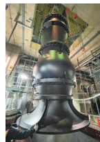
◀ポンプの据付 (立軸斜流ポンプ PSV型)
