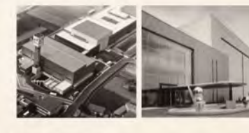
▲新京都工場竣工
