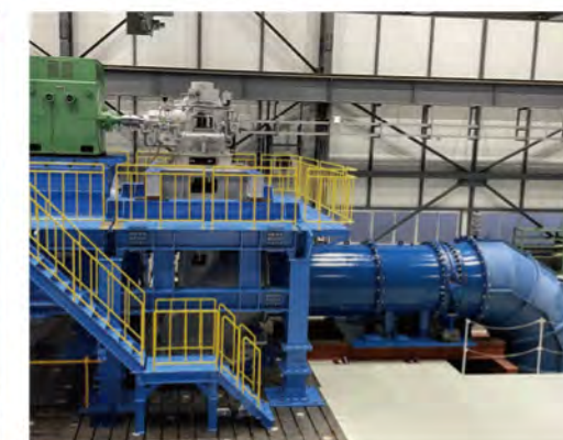
φ1800立軸斜流ポンプ試運転状況
